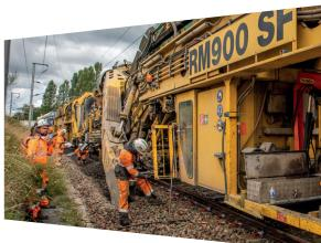
SNCF Réseau, gestionnaire du réseau ferré national, conduit une opération de grande ampleur qui consiste à renouveler 70 km de voies ferrées, dans le Loiret, entre Boisseaux et Les Aubrais. Ces travaux sont réalisés au moyen d'un train usine, qui permet de travailler 10 fois plus vite qu'avec des moyens traditionnels. Il renouvelle les principaux composants de la voie (rails, traverses et ballast) jusqu'à 1 km de voie par jour.
